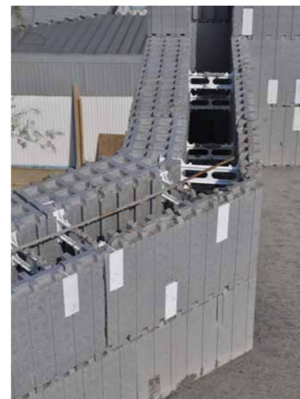
Использование петельных элементов для формирования углов под любым углом.
