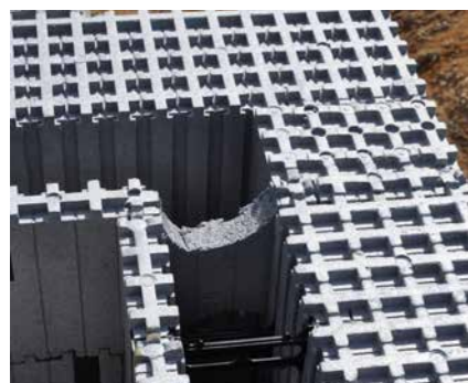
Удаление фрагмента элемента обеспечивает неразрывность бетонного наполнения.
