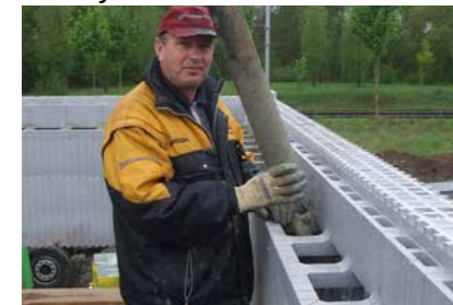
Укладываем бетон с помощью бетононасоса со скоростью укладки порядка 6-9 м 3 , таким способом можем закачать 40-70 м 3 стен в течение всего 1 часа!
