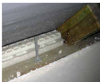
Элемент МР позволяет уложить арматуру обвязки в оси стены и опоры перекрытия.
