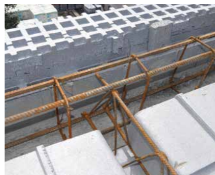
Элемент МР позволяет уложить арматуру обвязки в оси стены и опоры перекрытия.
