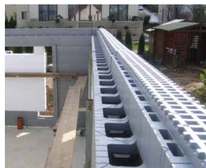
Элемент обвязки МР имеет наружный слой изоляции, той же, что вся стена.
