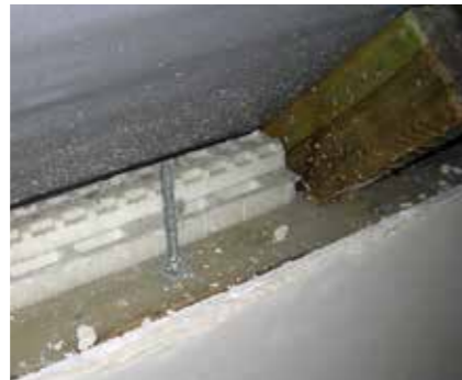
Das Element MP ermöglicht das Verlegen der Bewehrung des Ringankers in der Wandachse sowie das Stützen der Decke
