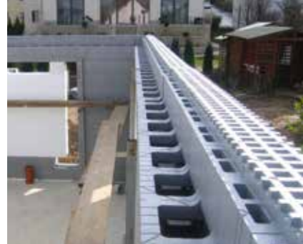
Das Ringankerelement MP besitzt die gleiche äußere Isolierschicht wie die ganze Wand.
