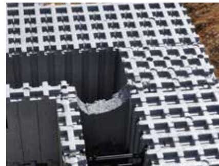
Das Beseitigen des Fragments eines Elements gewährleistet die Kontinuität des Ausfüllens mit Beton.
