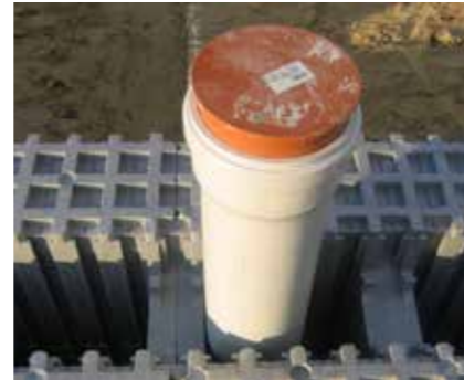
Das Element MP ermöglicht das Verlegen der Bewehrung des Ringankers in der Wandachse sowie das Stützen der Decke
