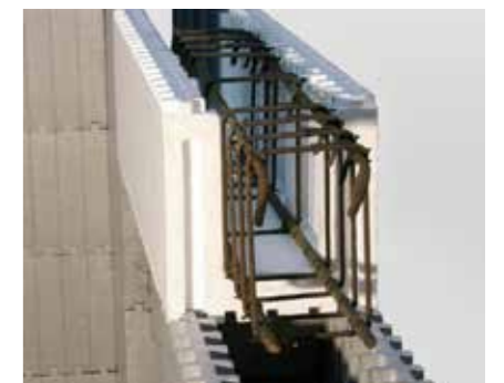
Im Sturzelement ML ist das Verlegen der Bewehrung einfach.
