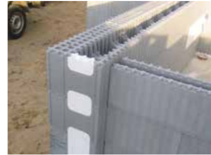
Baut man die Leibungen und stumpfe Wandabschlüsse – die Öffnungen in der Verschalung, schließt man mit den Elementen OH, OB und OC.
