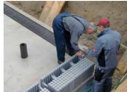
Erste Schicht der Elemente.
