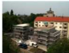
Dachgeschoß wird gesteckt und betoniert.
