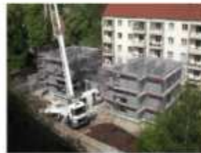
Neopor Steine werden mit Beton verfüllt.
