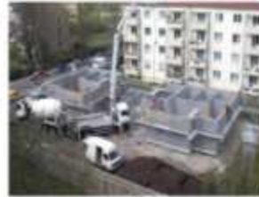
Neopor Steine werden mit Beton verfüllt.
