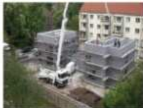
Dachgeschoß wird gesteckt und betoniert.
