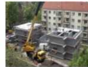
Fertigdecke wird verlegt.
