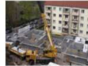
Fertigdecke wird verlegt.
