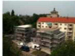
Dachgeschoß wird gesteckt und betoniert.
