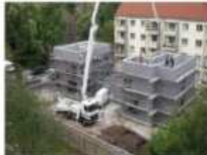
Dachgeschoß wird gesteckt und betoniert.
