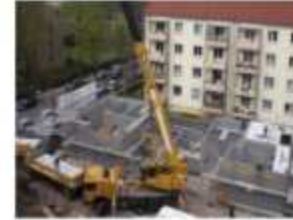
Fertigdecke wird verlegt.
