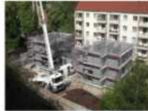
Neopor Steine werden mit Beton verfüllt.
