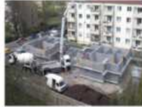
Neopor Steine werden mit Beton verfüllt.
