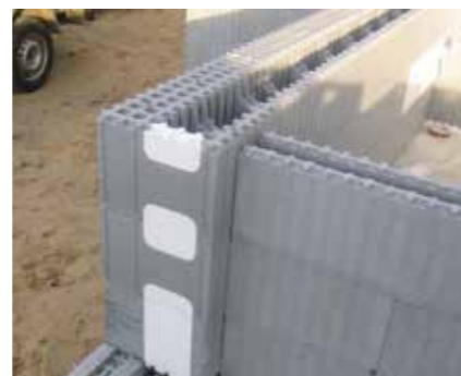
En construisant les embrasures et les extrémités émoussées des murs – on bouche les orifices par des éléments OH, OB et OC.
