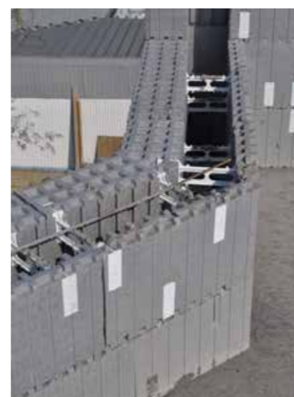
Utilisation d'éléments à charnière pour la formation des angles de mur sous angle quelconque.
