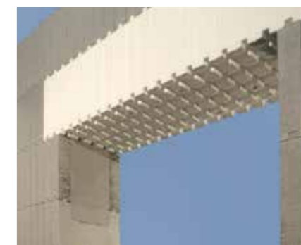
Linteau. L'élément du linteau a en coupe une forme de lettre U.
