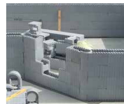
Utilisation d'éléments à charnière pour la formation des angles de mur sous angle quelconque.
