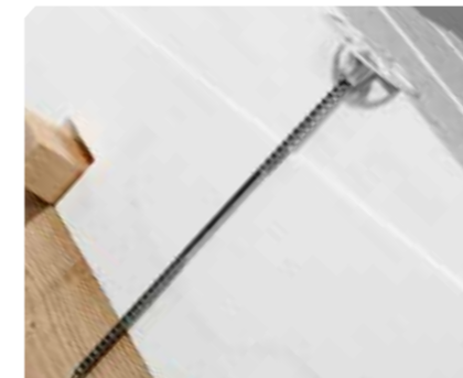
برغي تمدد يستخدم لتثبيت لوح السطح من إيزودوم.
