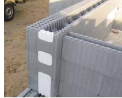
عند بناء نهايات الجدار الفظة والمكشوفة، قم بإغلاق الفتحات في صبة الخرسانة باستخدام عنصر OH أو OB أو OC.
