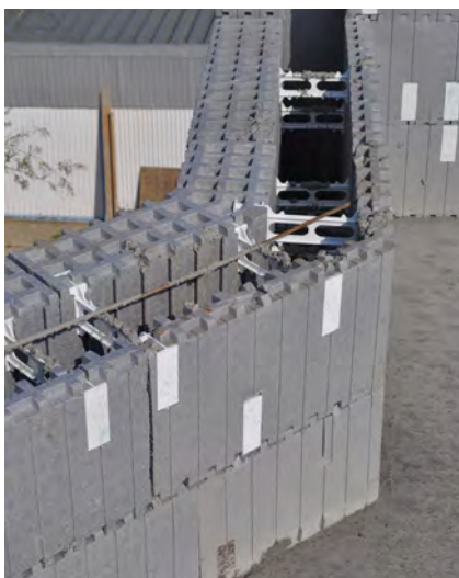
Uso de los componentes de bisagra para formar esquinas con cualquier ángulo.
