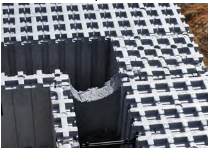
La eliminación de un fragmento del componente garantiza la continuidad del relleno con hormigón.
