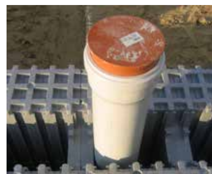
Elementul MP permite așezarea armăturii grinzii de coronament în axa peretelui și suportul podelei.
