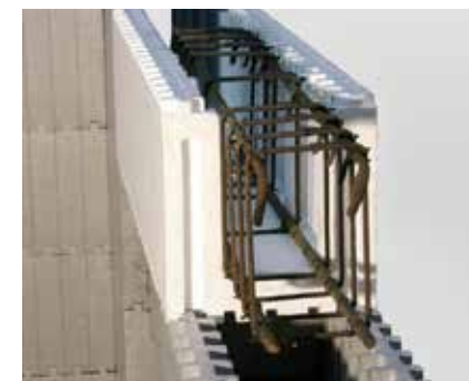
Amplasarea armăturii în elementul buiandrug ML este simplă.
