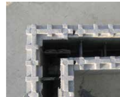
Element MCF 1/15 im Eckwinkel.
