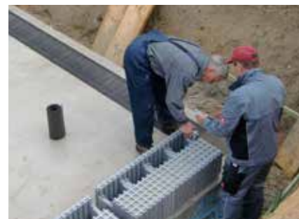
Erste Schicht der Elemente.
