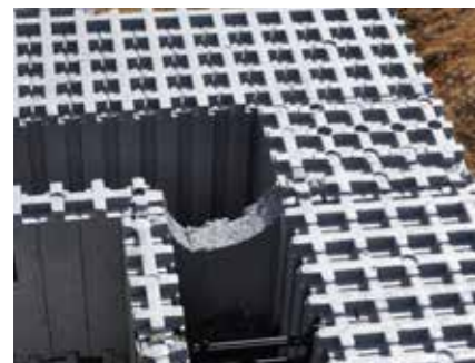
Das Beseitigen des Fragments eines Elements gewährleistet die Kontinuität des Ausfüllens mit Beton.
