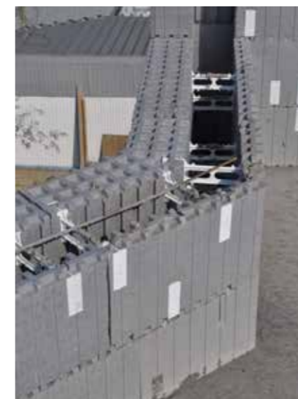
Anwendung von Scharnierelementen für die Gestaltung von Eckstücken unter einem beliebigen Winkel
