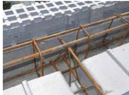
Das Element MP ermöglicht das Verlegen der Bewehrung des Ringankers in der Wandachse sowie das Stützen der Decke
