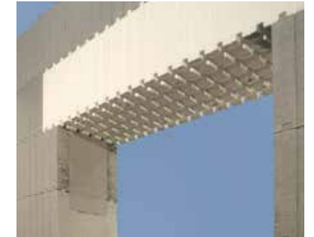
Sturz. Das Sturzelement hat im Querschnitt die Form des U-Buchstaben.
