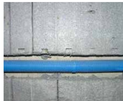
Die Abbildung zeigt einen sehr guten thermischen Schutz, welchen die Anwendung des Elementes MP beim Bau eines Kniestocks gewährleistet. Die Kontinuität der Isolierschicht schützt das Gebäude vor Wärmeverlust und Feuchtigkeit.
